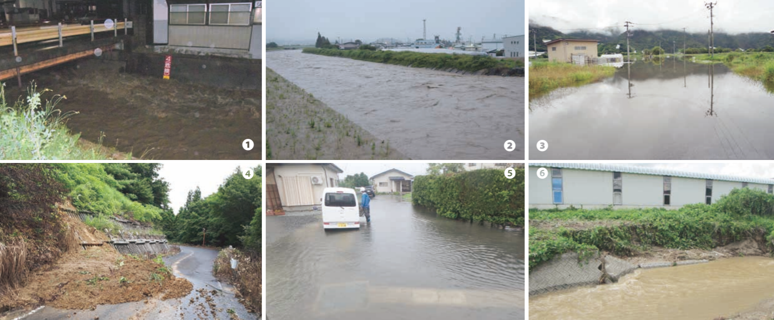
①水位が上昇した織機川（川原橋付近）と②吉野川（花台橋下流）③冠水した白竜湖周辺の道路（赤湯市内）④土砂崩れ（吉野市内） ⑤冠水した道路（宮内市内）⑥護岸が崩落した織機川織鶴橋上流右岸
