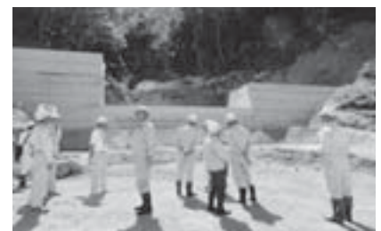
川樋南沢砂防ダム工事現場
