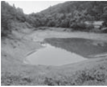
川樋 唐沢ため池
