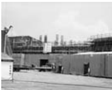
建設中の宮内中学校
