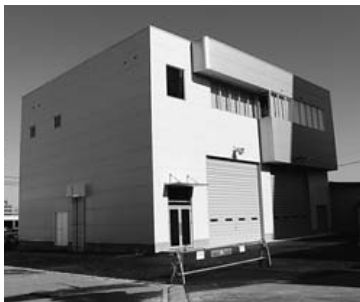
広域消防指令センター
