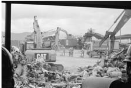
大きいものは重機により破碎分別する
