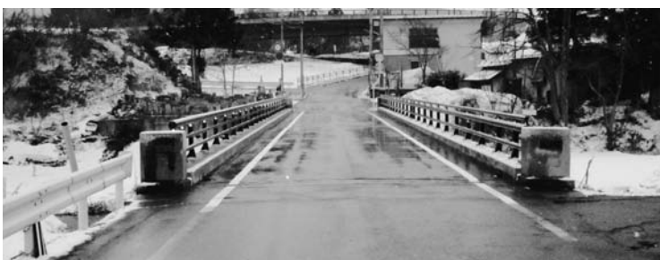
宮内原橋の補修工事が完成
