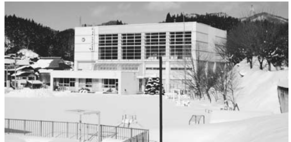
利活用がのぞまれる旧小滝小
