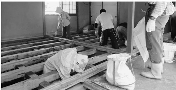
床下の土砂をかき出すボランティア
