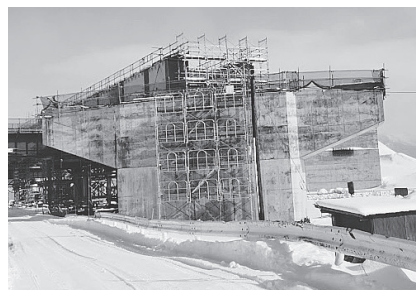
工事が進む南陽・高畠IC
