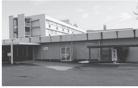
改築される南陽病院
