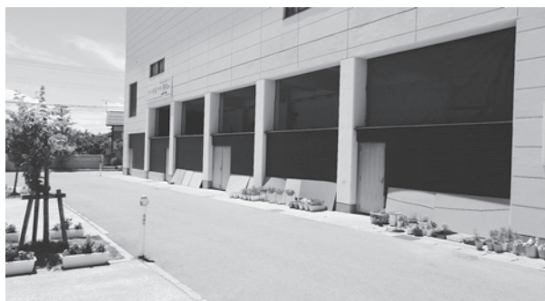
宮内中体育館ピロティ
